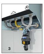
Si el espacio debajo de la caldera no admite el uso del kit de tubos rígidos, el racor excéntrico en "S" del desfangador cód. 545205 permite ahorrar espacio de trabajo debajo de la caldera alejando el desfangador hacia abajo (4 y 5). Las conexiones se realizan entonces con tubos flexibles de acero inoxidable.
