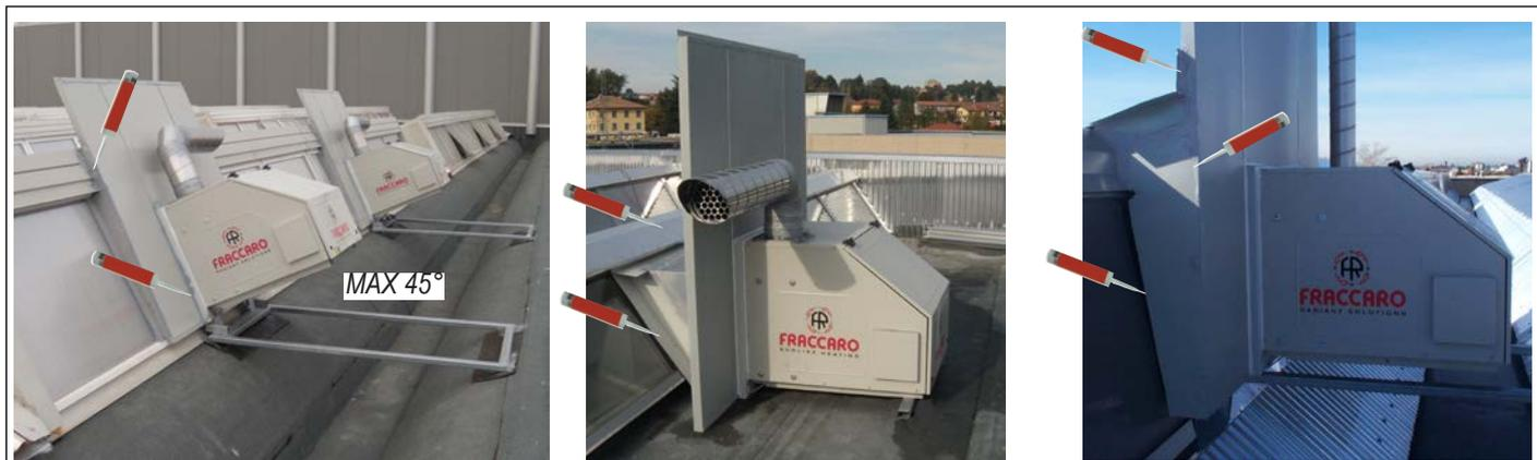
Es posible, de acuerdo con la estructura del marco de la ventana, la inclinación máxima de 45° del generador.
