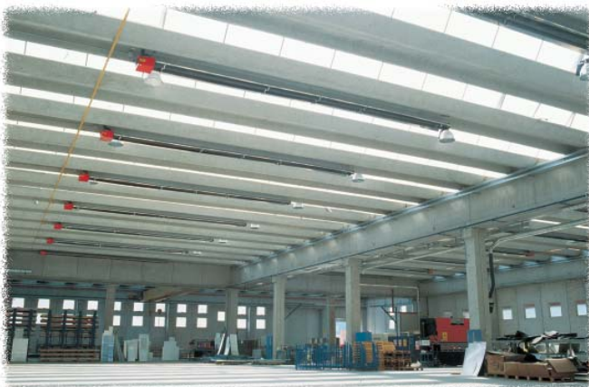
Fig. 10 Instalación Panrad: producción grupos de enfriamiento
