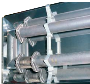
Fig. 8 Empalme de unión y dilatador
