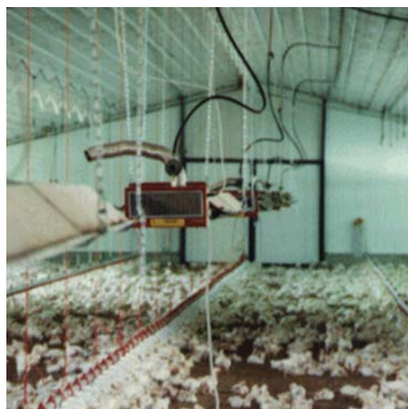
Fig. 55 Instalación Panrad Red-Line: avicultura
