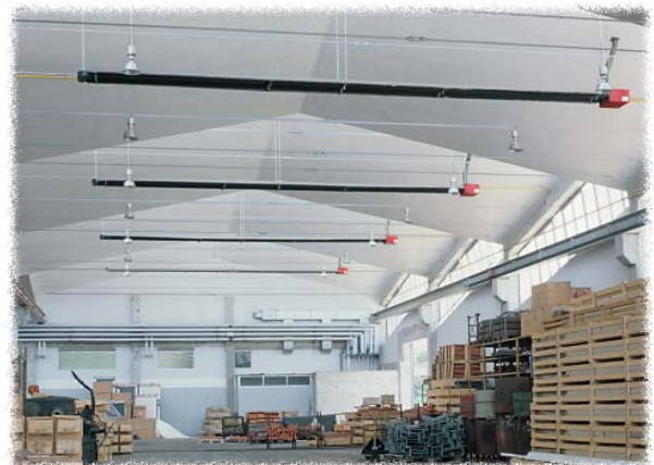
Fig. 11 Instalación Panrad: carpintería pesada
